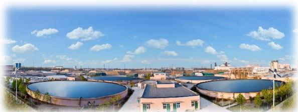
報告期內，生產基地總用水量達 89,943,399 立方米，人均用水密度為 8,126 立方米/人，用水密度則為 11.94 立方米/每產量單位(噸)。二零一九年度內，江西晨鳴紙業的廢水排放口錄得懸浮物排放濃度超出排放濃度 30mg/L 的排放要求。就此，生產基地已即時停止該區的污水排放，並在原先南、北曝氣池共 50 台表曝機的基礎上，再各增設 10 個射流曝氣裝置，以增加溶解氧，令二沉池出水 COD 含量下降百分之六十等，以實現達標排放。在此之外，本公司沒有錄得其他有關污水排放超標或違反環保法規的行為。
